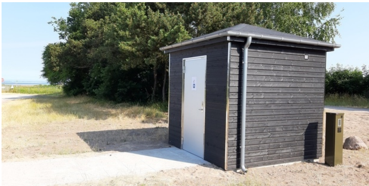
Toiletbygningen ved Dalby Huse Strand. Foto: Frederikssund Kommune.
