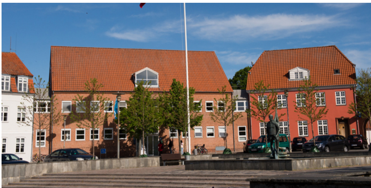
Frederikssund Rådhus. Foto: Frederikssund Kommune.
