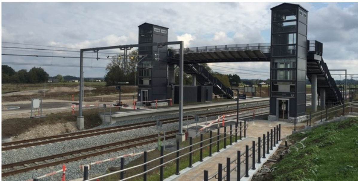
Vinge Station. Foto: Frederikssund Kommune.
