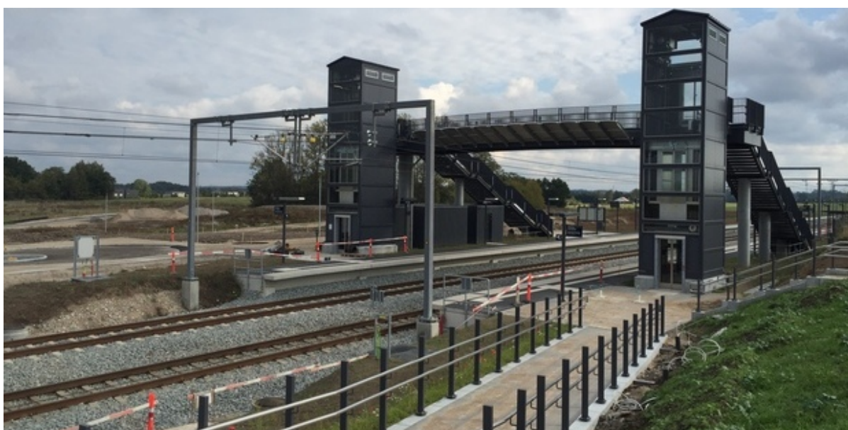
Vinge Station. Foto: Frederikssund Kommune.
