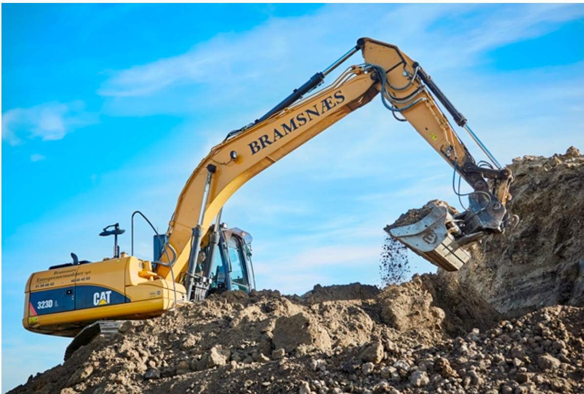
Gravemaskine flytter jord. Foto: Frederikssund Kommune.
