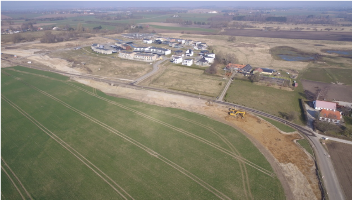
Vejarbejde på Dalvejen. Foto: Frederikssund Kommune.
