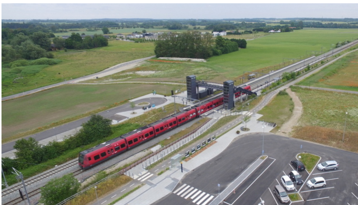
Vinge Station med parkeringspladser på begge sider. Foto: Frederikssund Kommune.
