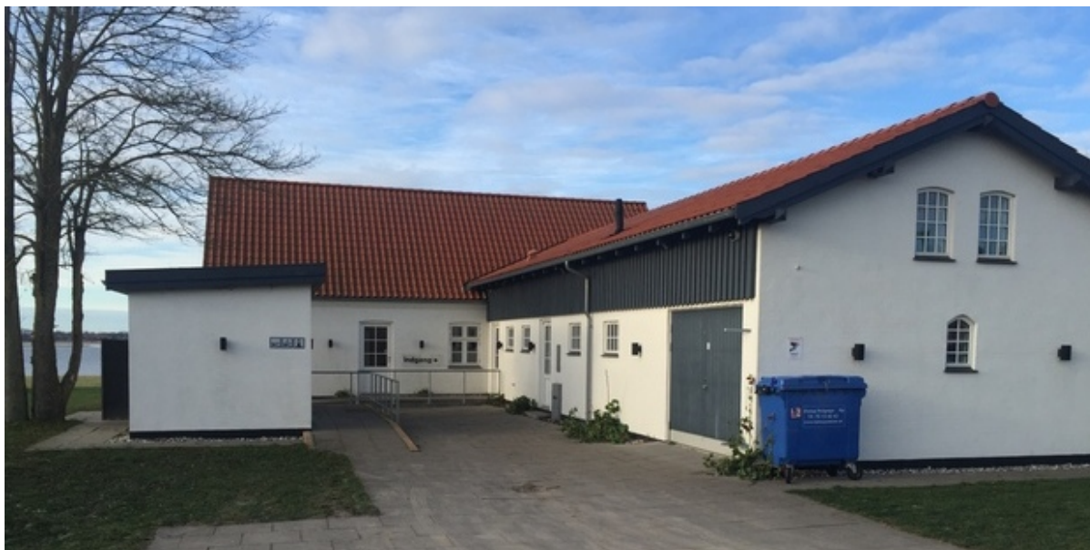
Østersvej 4. Foto: Frederikssund Kommune.
