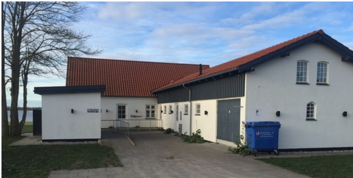
Østersvej 4. Foto: Frederikssund Kommune.
