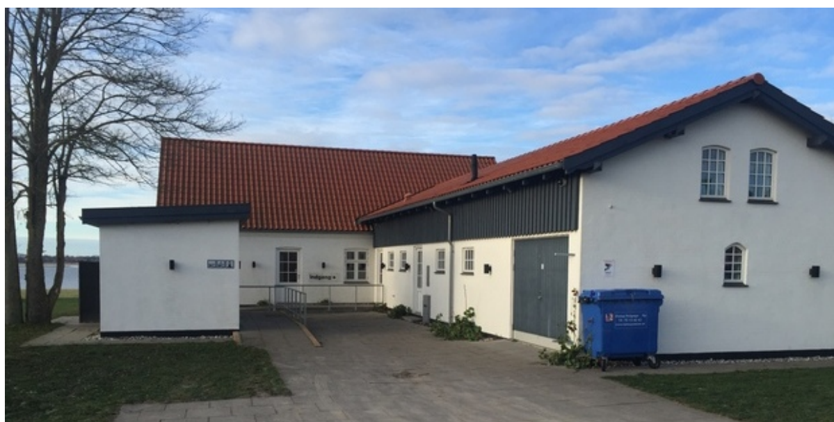
Østersvej 4. Foto: Frederikssund Kommune.
