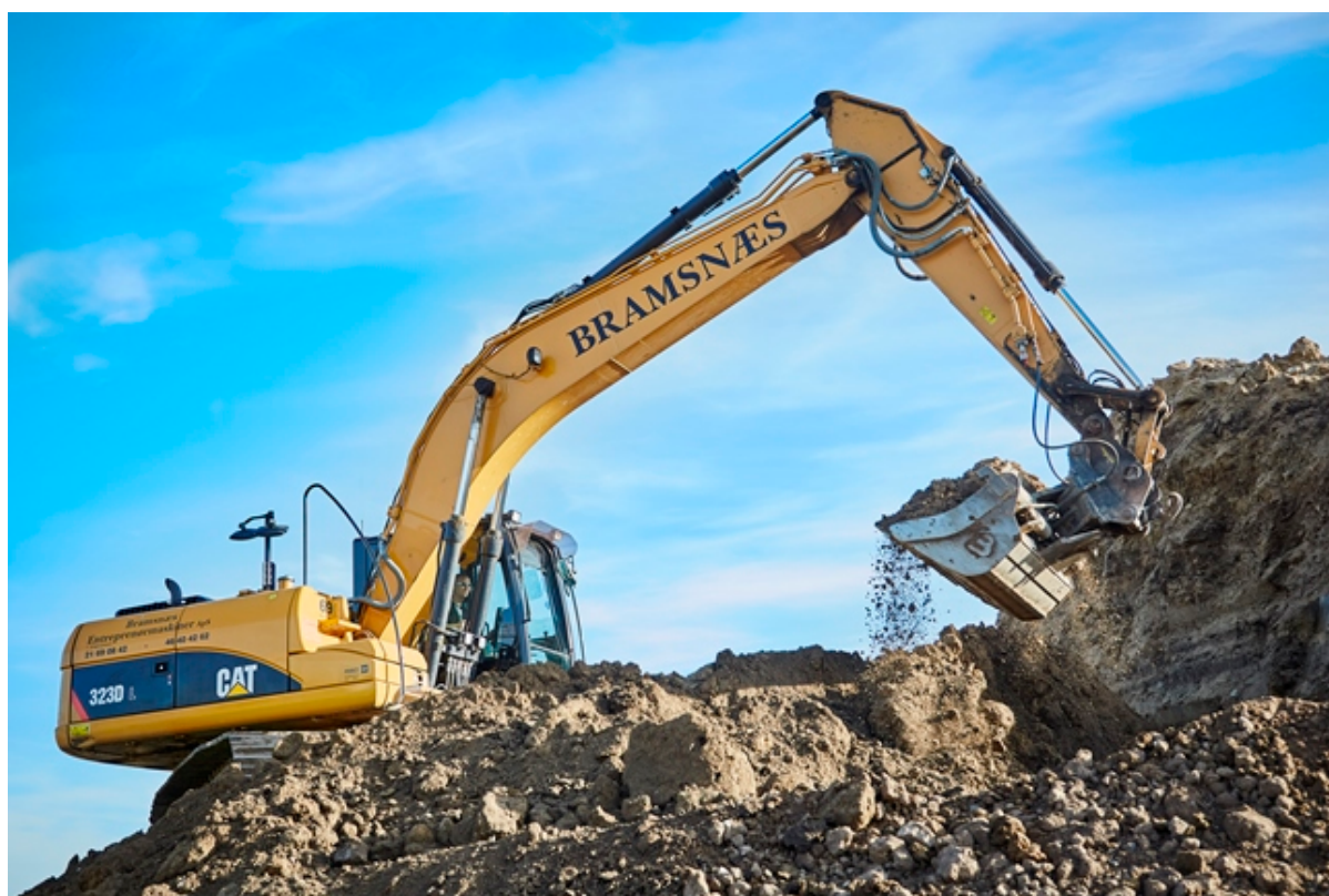
Gravemaskine flytter jord. Foto: Frederikssund Kommune.
