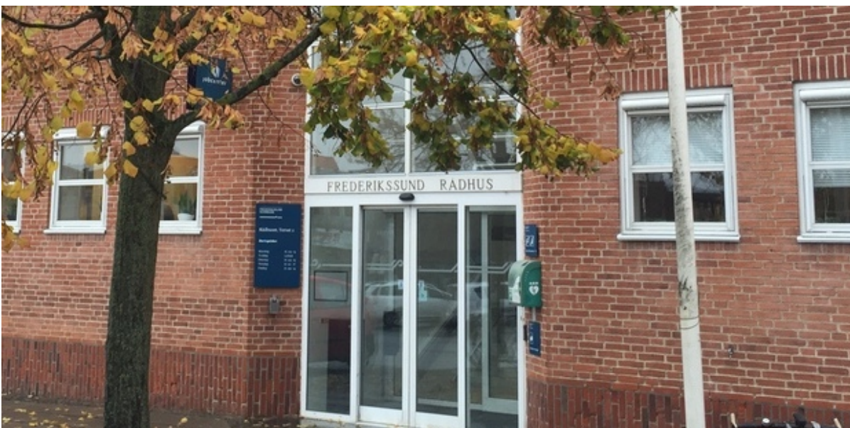
Indgangspartiet på Frederikssund Rådhus. Foto: Frederikssund Kommune.
