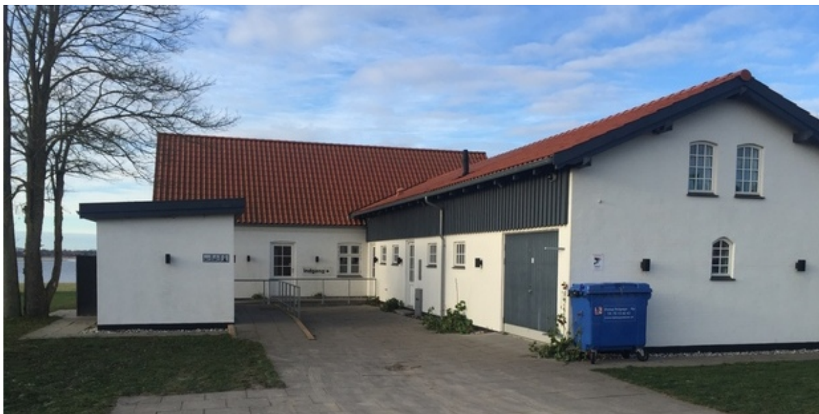
Østersvej 4. Foto: Frederikssund Kommune.
