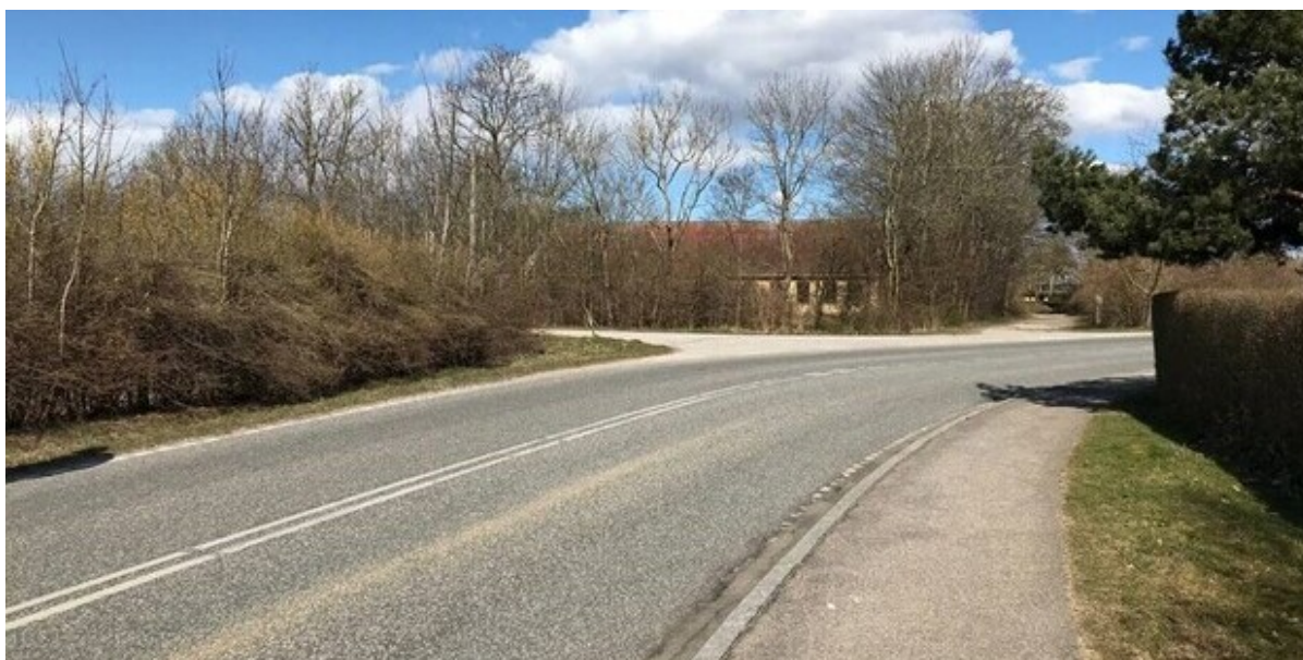
Jordhøjvej, Slangerup. Foto: Frederikssund Kommune.
