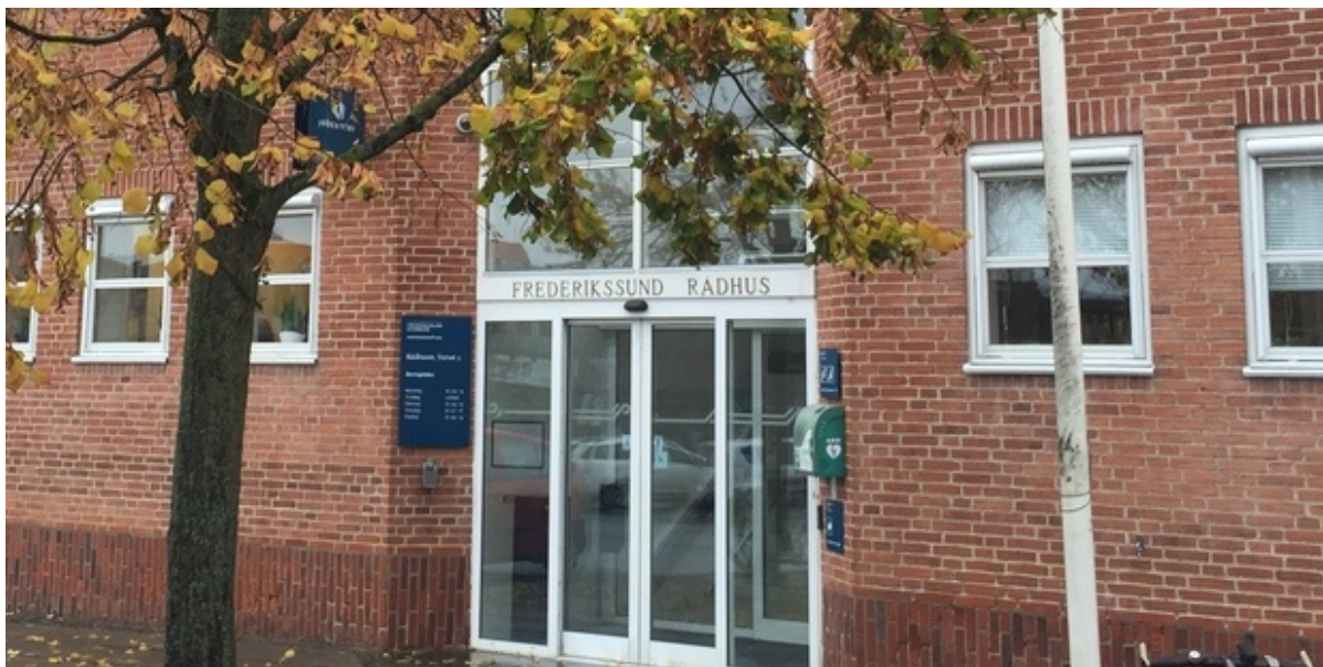
Indgangspartiet på Frederikssund Rådhus. Foto: Frederikssund Kommune.
