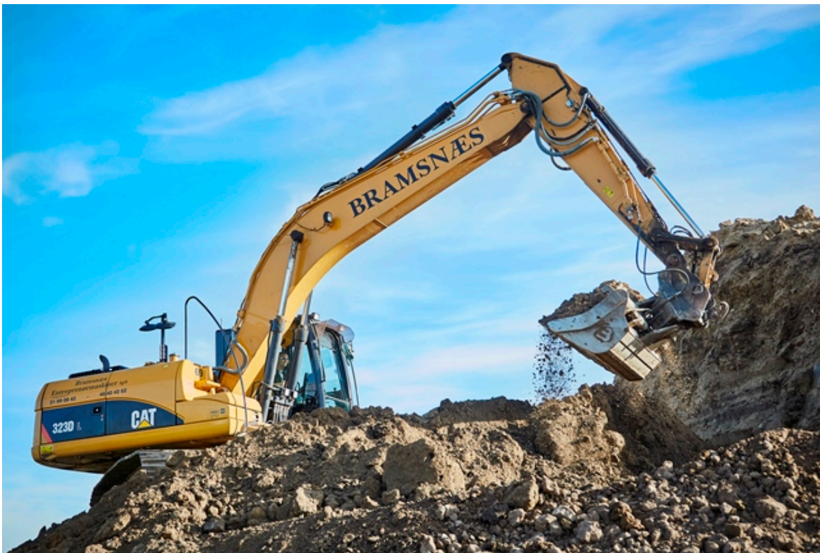
Gravemaskine flytter jord. Foto: Frederikssund Kommune.
