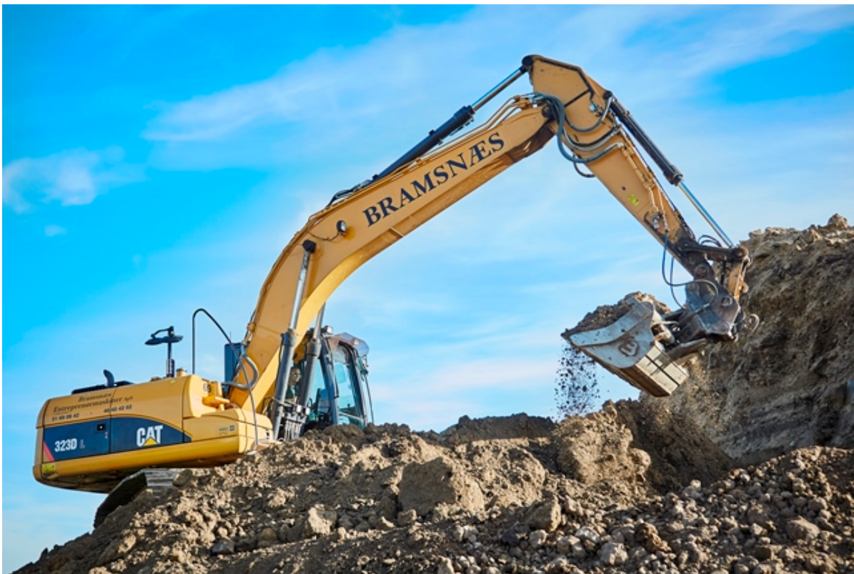
Gravemaskine flytter jord. Foto: Frederikssund Kommune.
