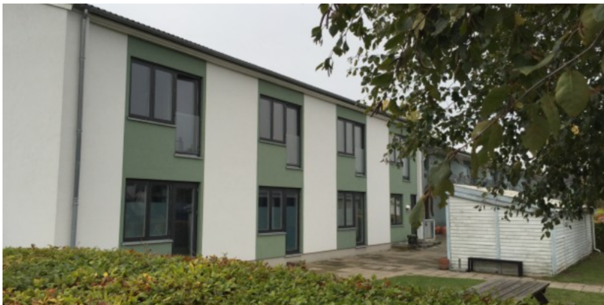
Ungdomsboligerne på Birkevænget. Foto: Frederikssund Kommune.
