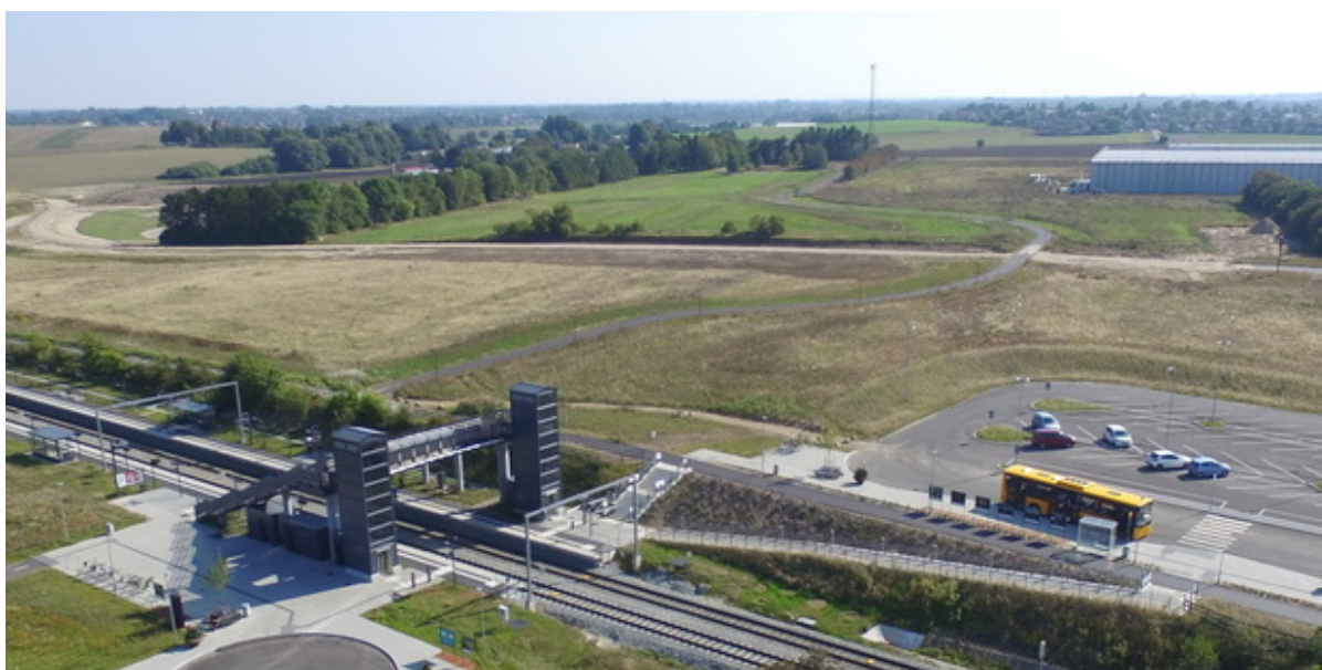
Vinge Station og p-plads. Foto: Frederikssund Kommune.
