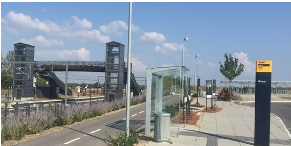
Vinge Station. Foto: Frederikssund Kommune.
