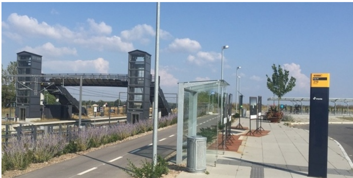
Vinge Station. Foto: Frederikssund Kommune.
