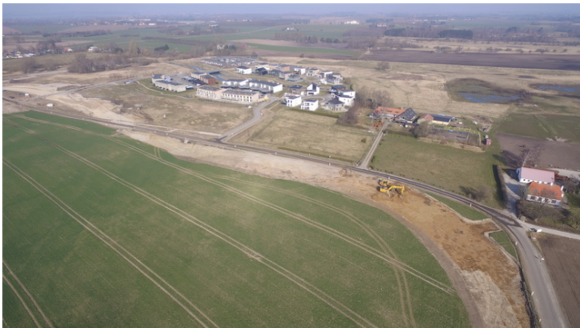
Vejarbejde på Dalvejen. Foto: Frederikssund Kommune.
