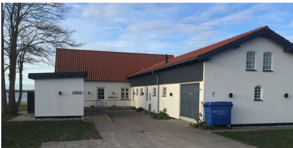
Østersvej 4. Foto: Frederikssund Kommune.
