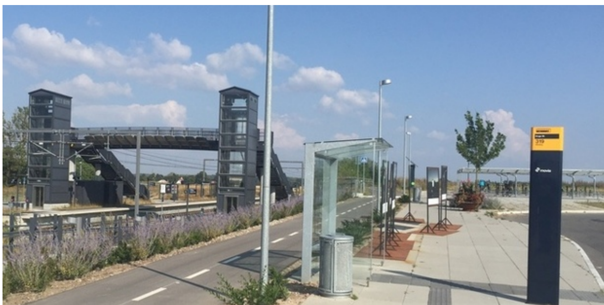
Vinge Station. Foto: Frederikssund Kommune.
