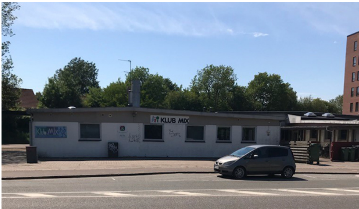
Facaden af Klub Mix. Foto: Frederikssund Kommune.
