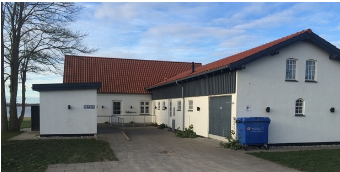
Østersvej 4. Foto: Frederikssund Kommune.
