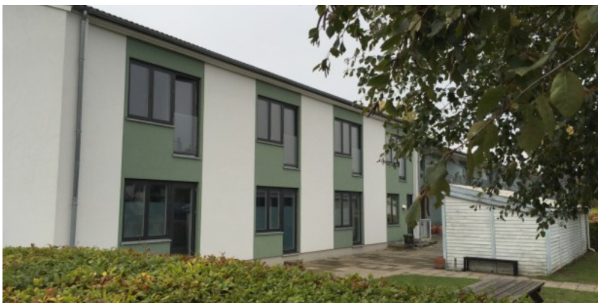
Ungdomsboligerne på Birkevænget. Foto: Frederikssund Kommune.
