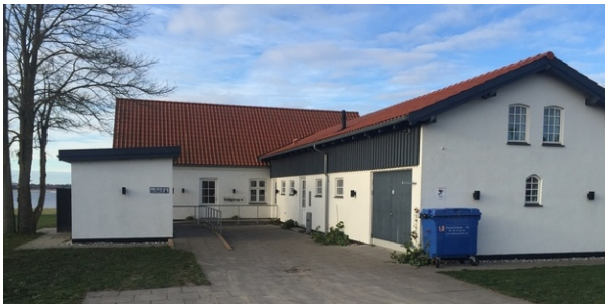
Østersvej 4. Foto: Frederikssund Kommune.
