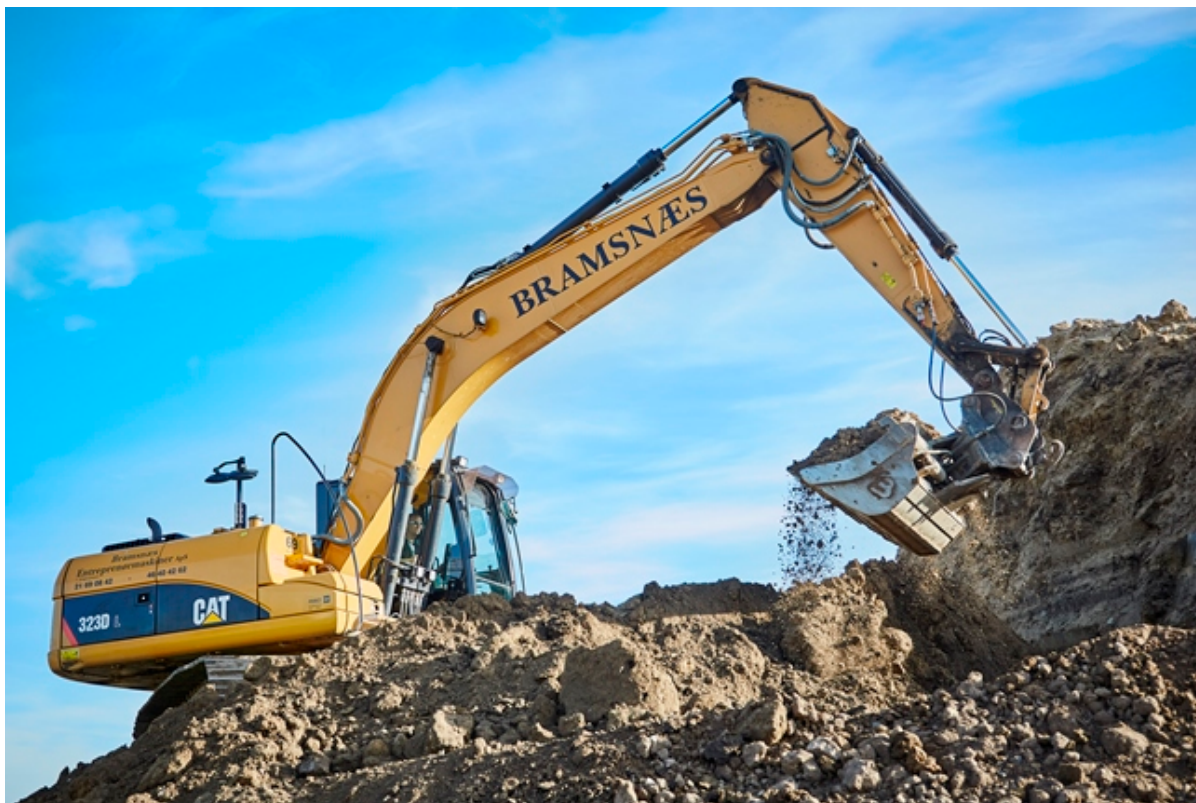
Gravemaskine flytter jord. Foto: Frederikssund Kommune.
