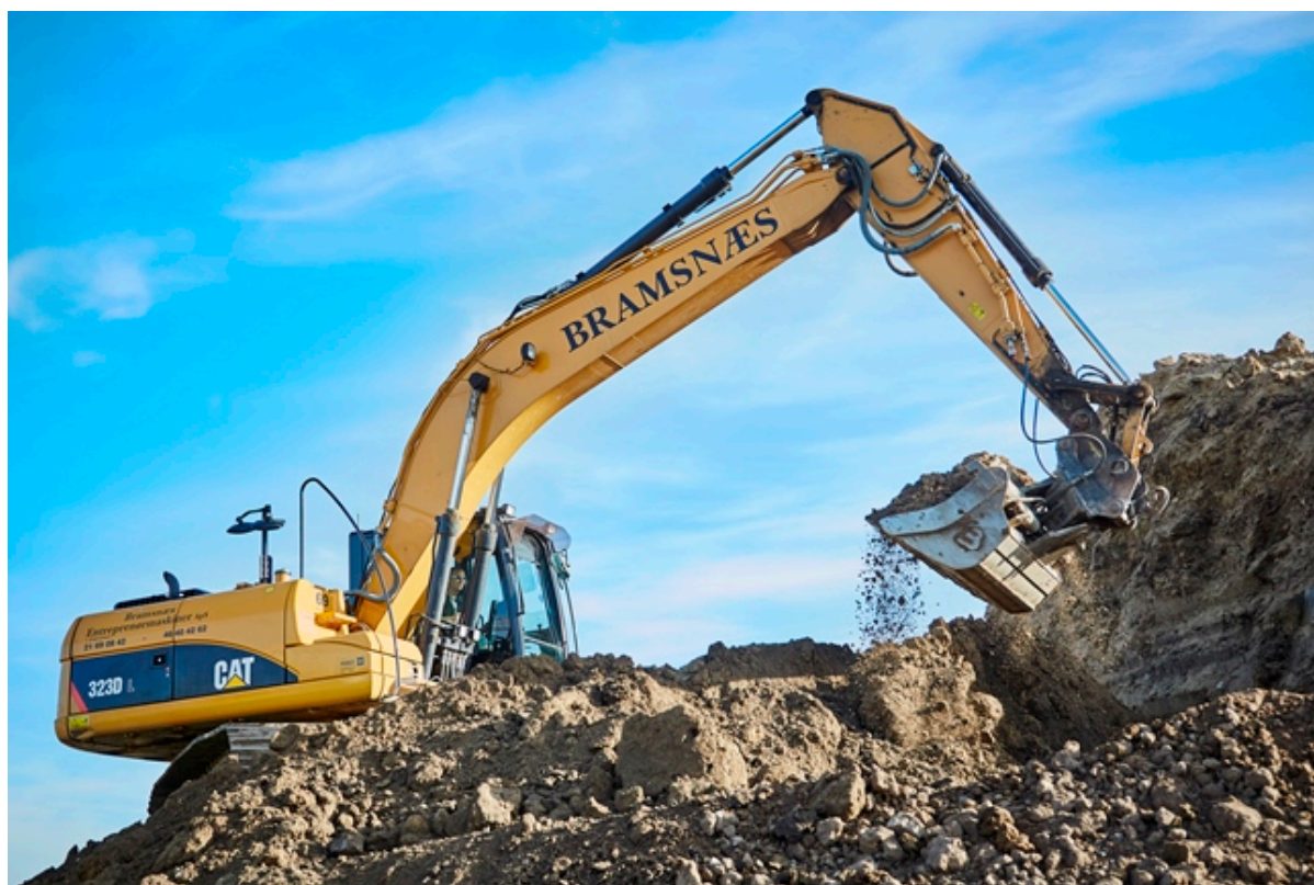
Gravemaskine graver i jorden. foto: Frederikssund Kommune.
