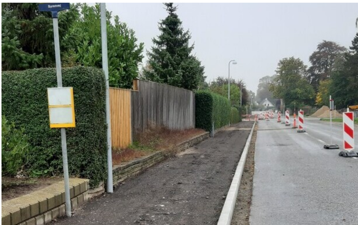
En del af strækningen på Saltøvej i Skibby, hvor der arbejdes med anlæggelse af ny fællessti. Foto: Frederikssund Kommune.
