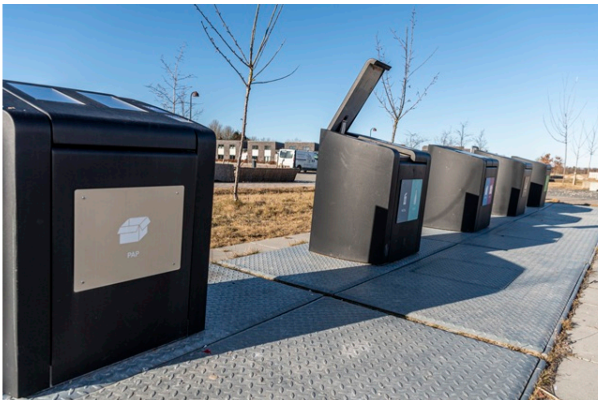
Nedgravede affaldscontainere i Vinge. Foto: Kenneth Jensen.
