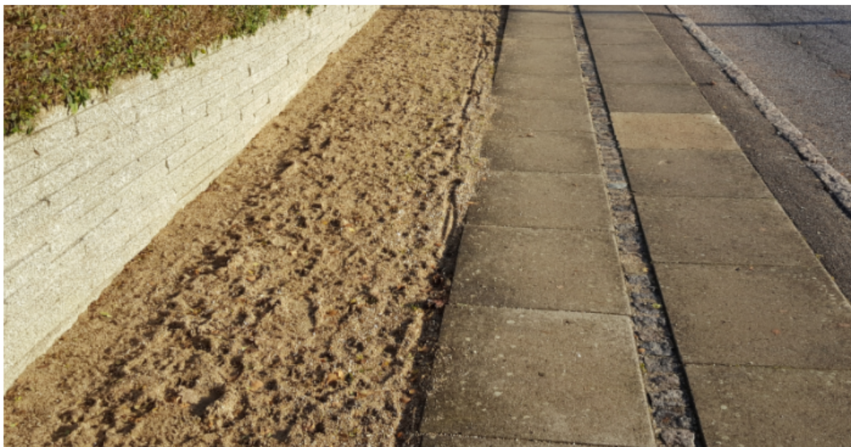
Et pænt ryddet fortov. Foto: Frederikssund Kommune.
