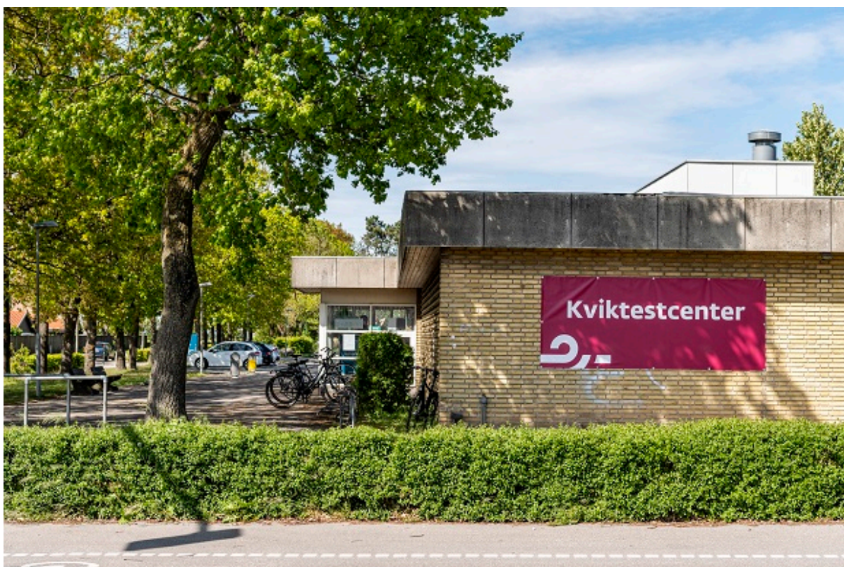
Testcenter i den gamle svømmehal på Odinsvej i Frederikssund. Foto: Frederikssund Kommune, Kenneth Jensen.
