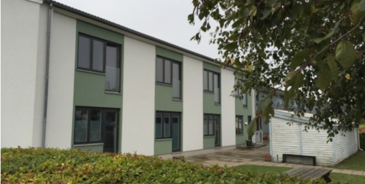
Ungdomsboligerne på Birkevænget. Foto: Frederikssund Kommune.
