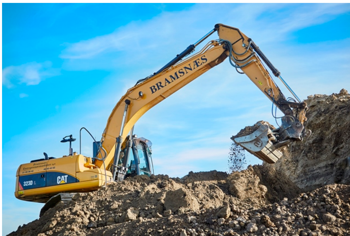
Gravemaskine graver i jorden. foto: Frederikssund Kommune.
