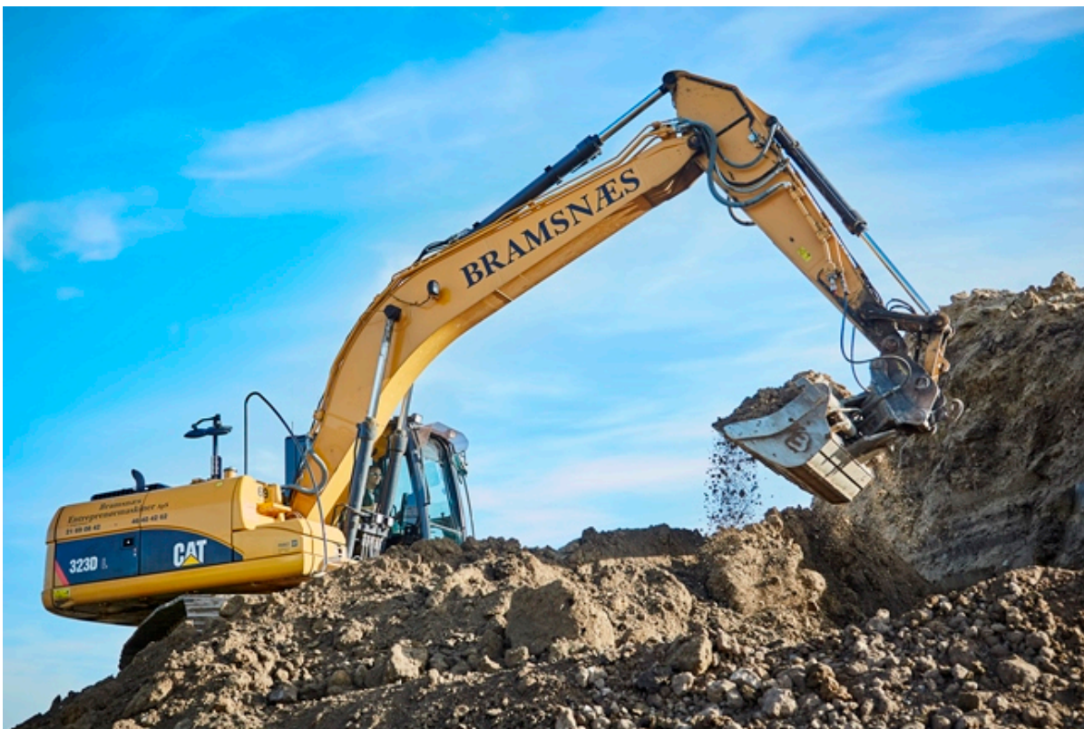
Gravemaskine graver i jorden. foto: Frederikssund Kommune.
