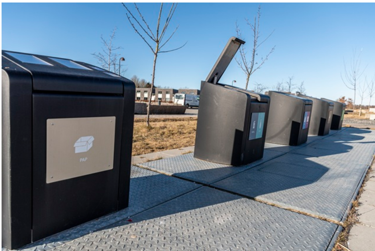
Nedgravede affaldscontainere i Vinge. Foto: Kenneth Jensen.
