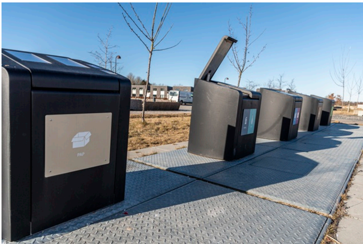
Nedgravede affaldscontainere i Vinge. Foto: Kenneth Jensen.
