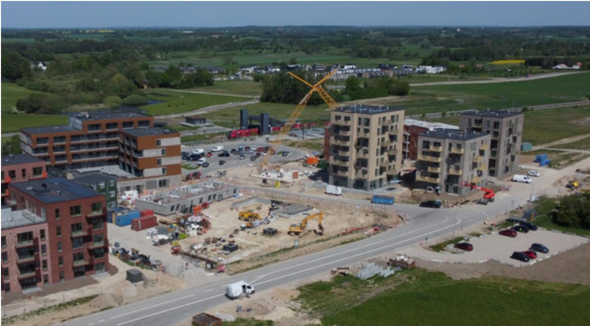
Byggeri i centrum af Vinge. Foto: Frederikssund Kommune.
