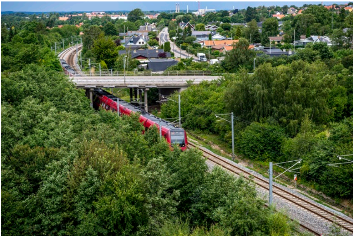
Jernbanebroen på Strandgade i Frederikssund. Foto: Kenneth Jensen.
