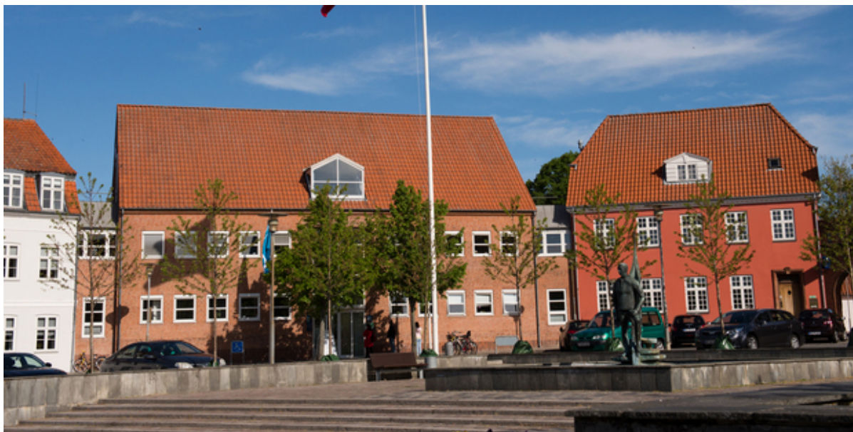
Frederikssund Rådhus. Foto: Frederikssund Kommune.
