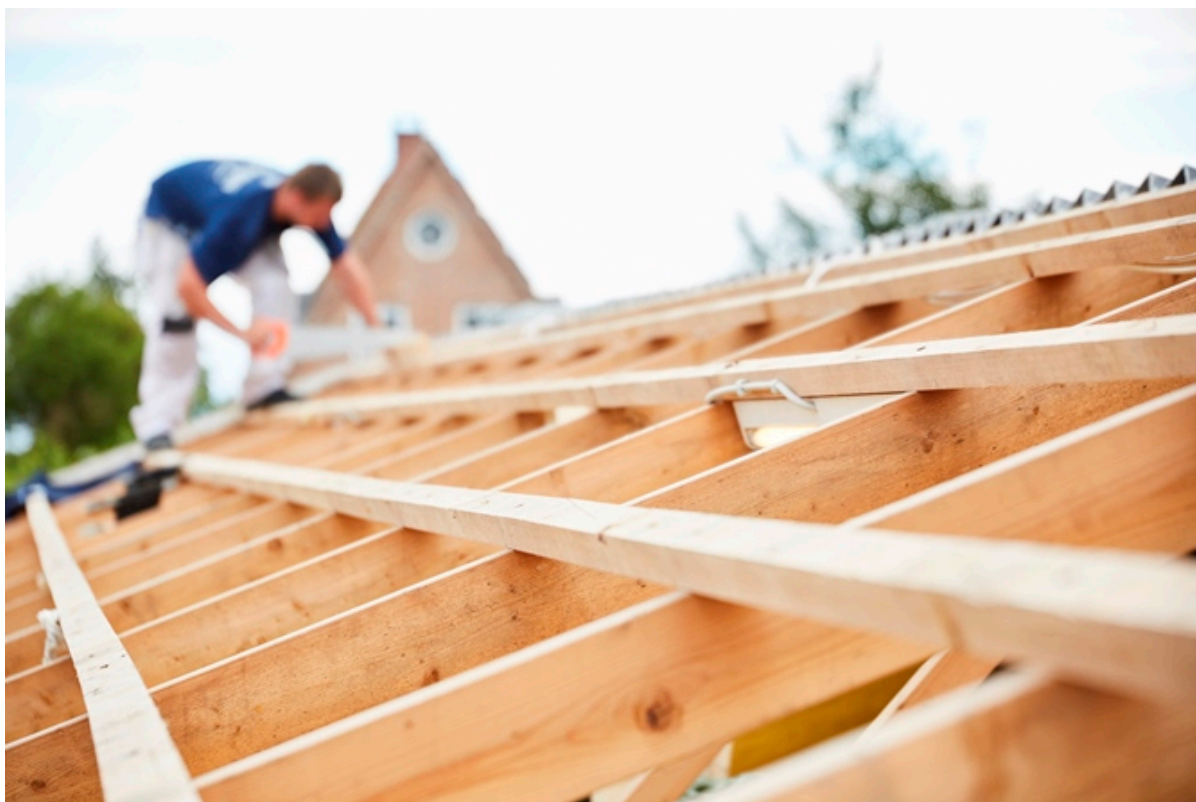
Tømrer arbejder på et hustag. Foto: Frederikssund Kommune.
