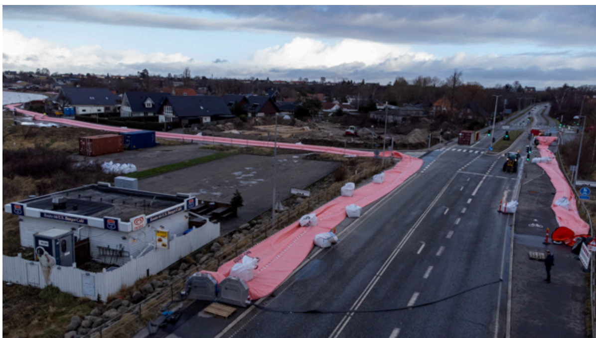
Dronefoto af watertube langs Strandvej i Frederikssund. Foto: Kenneth Jensen, Frederikssund Kommune.
