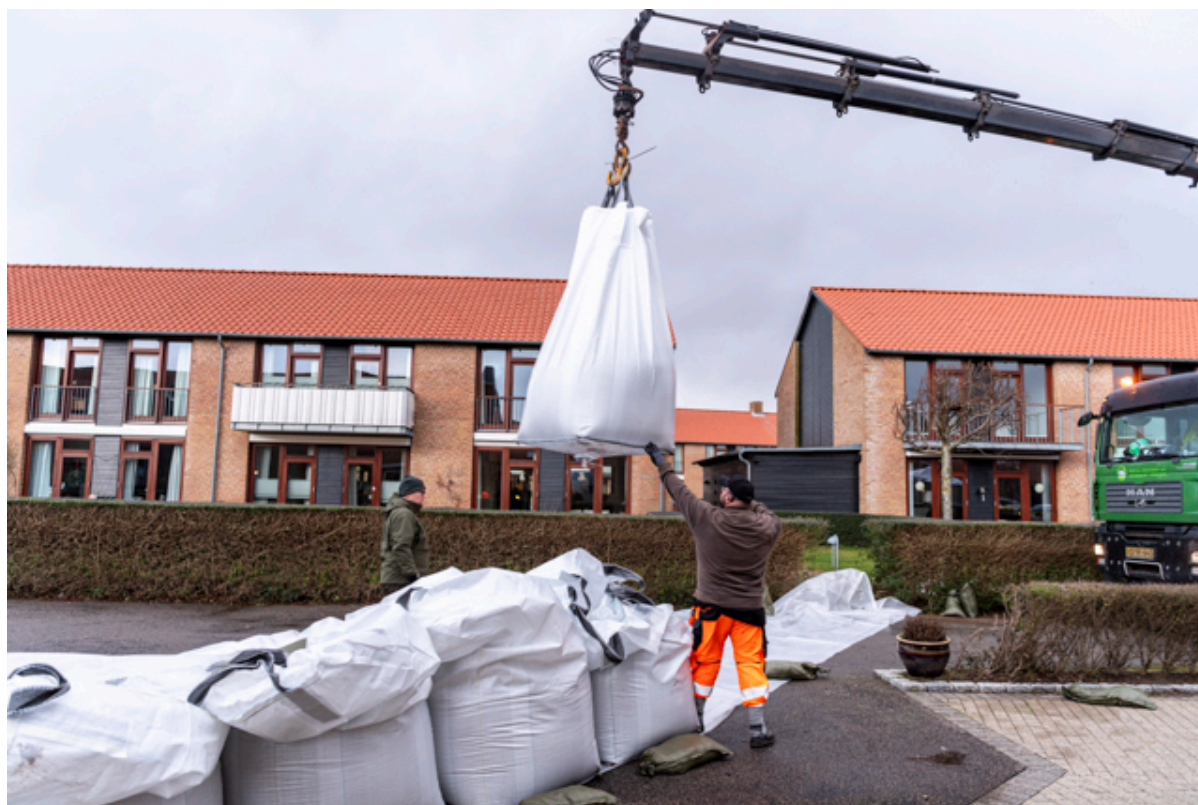
Der etableres ekstra dige på Nordre Pakhusvej i Frederikssund. Foto: Kenneth Jensen, Frederikssund Kommune.
