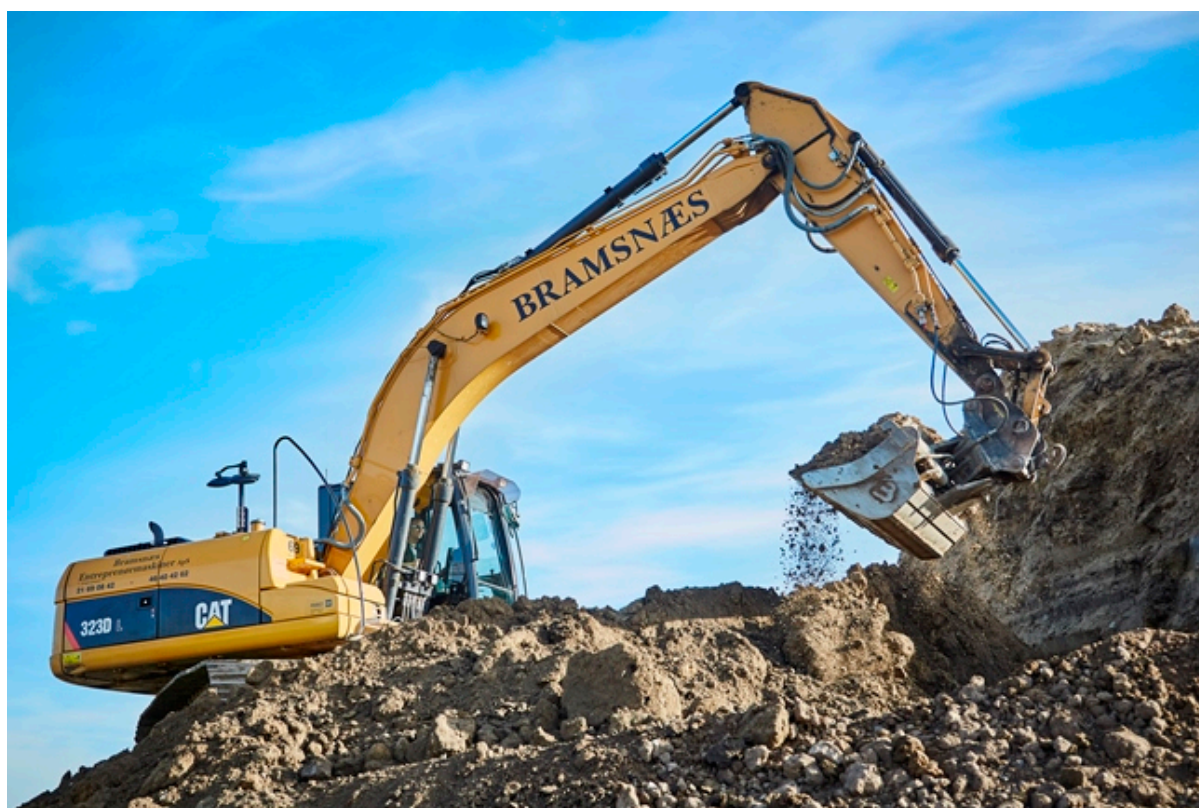
Gravemaskine graver i jorden. foto: Frederikssund Kommune.
