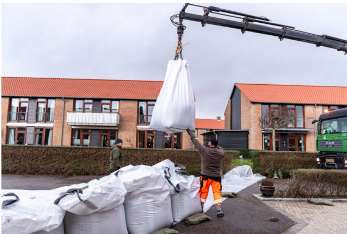
Der etableres ekstra dige på Nordre Pakhusvej i Frederikssund. Foto: Kenneth Jensen,
