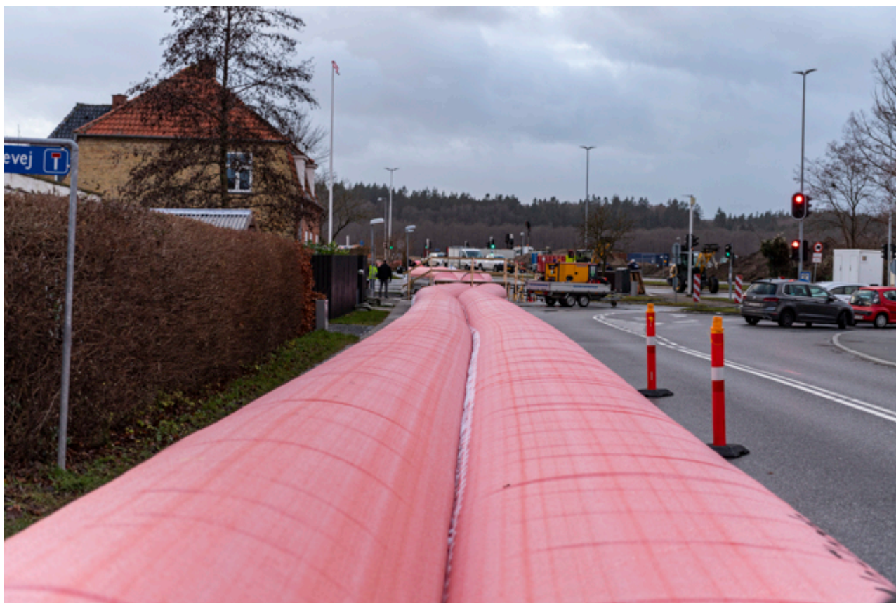
Watertubes på Færgevej.
