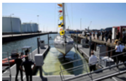
Flydende vaskeplads med rensningsanlæg
