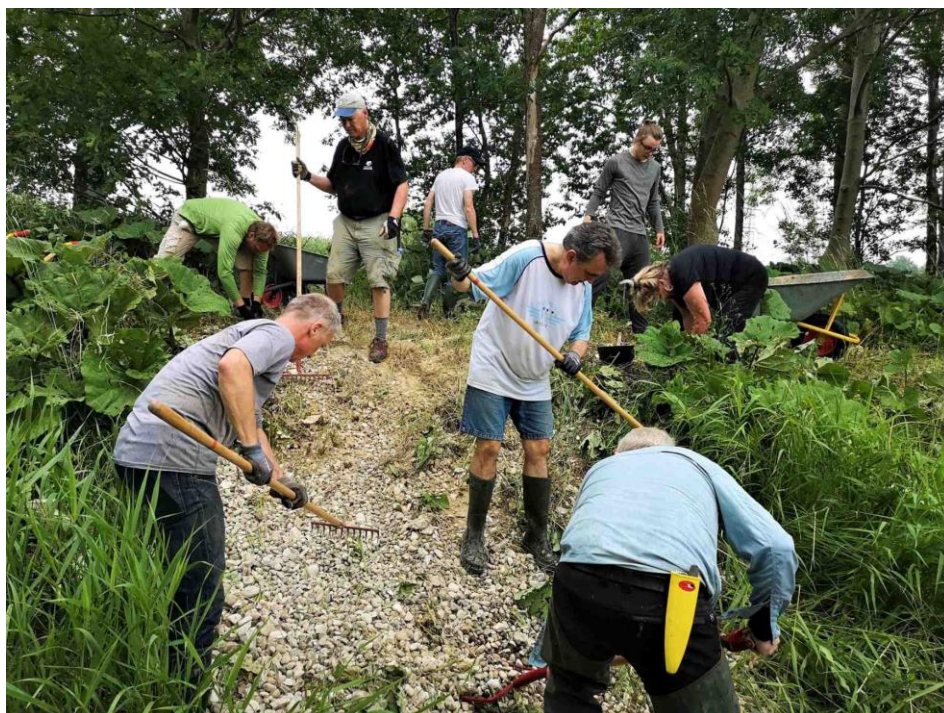
Figur 14 - Ølsted og Frederiksværk Sportsfiskerforenings vandplejegruppe og Grusbanden har i sommeren 2021 udlagt ca. 80 tons gydegrus og sten i Græse Å, for at skabe bedre betingelser for ørred.
